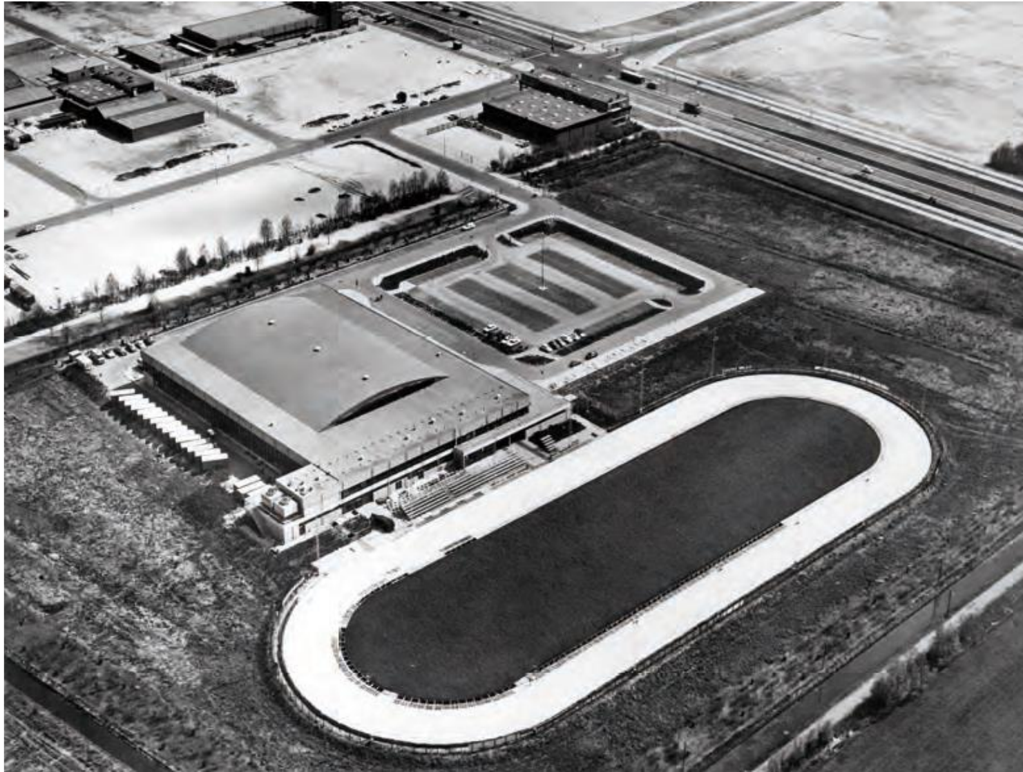
Kunstijsbaan Utrecht (1970) Koelinstallatie Landaal Schelde
